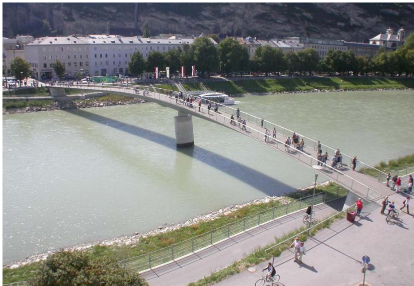
Abb.3: Der Makartsteg für Fußgänger und Radfahrer in Salzburg (aus: Webseiten der Stadt Salzburg); man beachte die kreuzungsfrei geführten Uferwege unter der Brücke.
